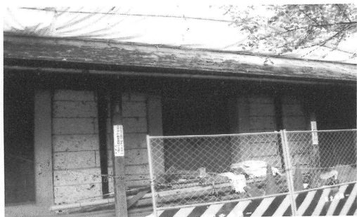
神輿倉も工事の為すべて移動されています
